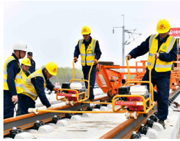
日兰高铁曲阜至菏泽段开始铺轨
